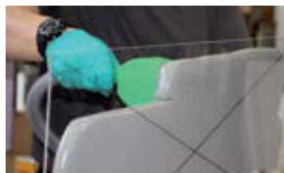
SC175 thixotropie dovoluje vertikální aplikace v jedné vrstvě a bez stékání.
